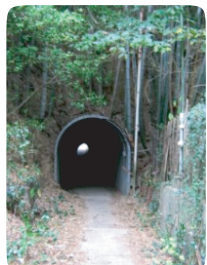
軍用トンネル (通行できます)
