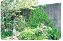
第一検疫所の遺構
